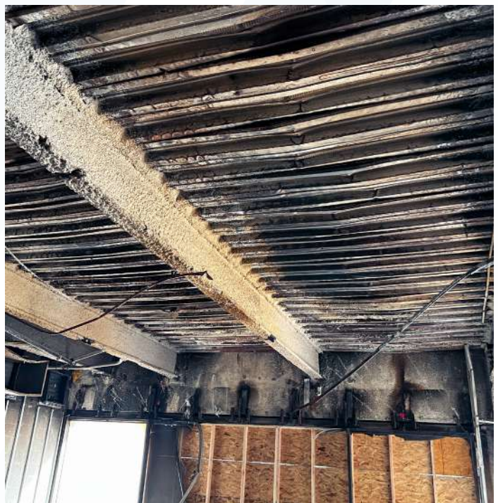
Ảnh chụp ngày 28 tháng Hai, 2023 sau khi khắc phục cho thấy cột bị hư hại (trên cùng bên trái), cơ sở hạ tầng điện và thông tin liên lạc (trên cùng bên phải) và ván sàn tầng lầu hai (dưới cùng).
